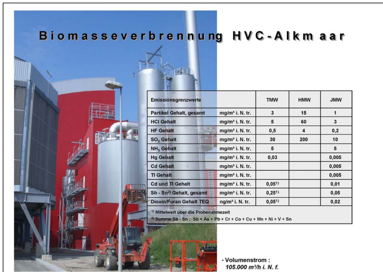
Abb. 10: Gasreinigung Biomasseverbrennung bei der HVC in Alkmaar
